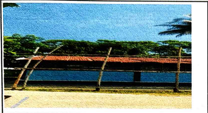
Foto1: Cambio de techo
