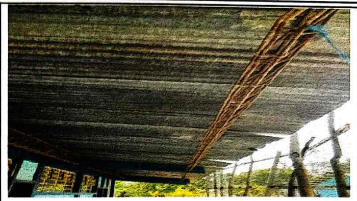
Foto 2: Cambio de costanera
